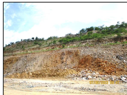
ภาพที่ 2.7 การนำเศษหินและเศษดินทำคันดินสำหรับปลูกต้นไม้บริเวณพื้นที่ที่ผ่านการทำเหมือง
