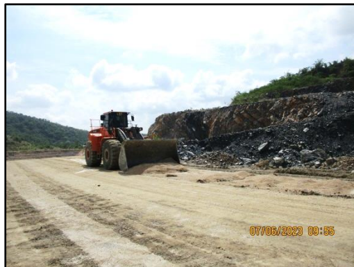
ภาพที่ 2.12 การบดปรับพื้นที่เส้นทางถนนบนเหมือง
